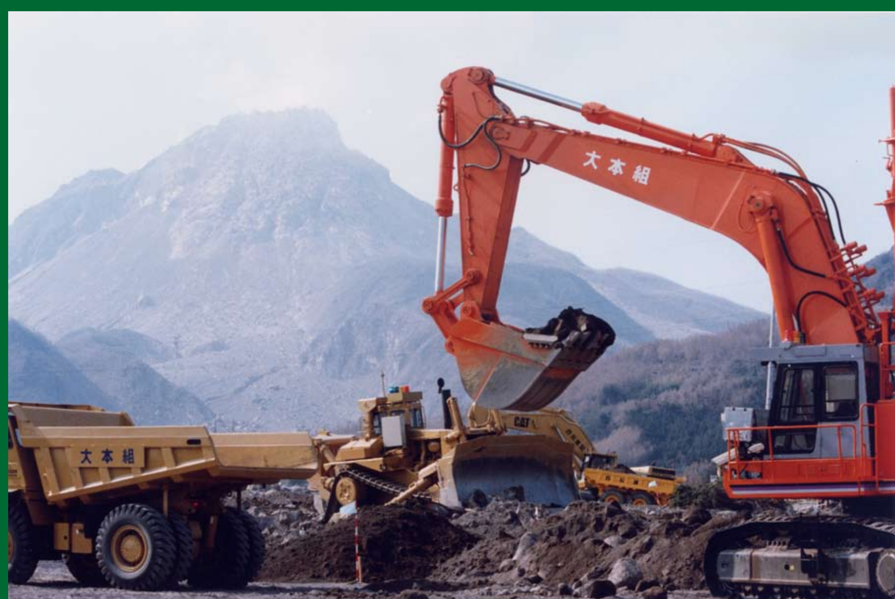
試験フィールド制度活用による試験施工（除石） [1994/03]
