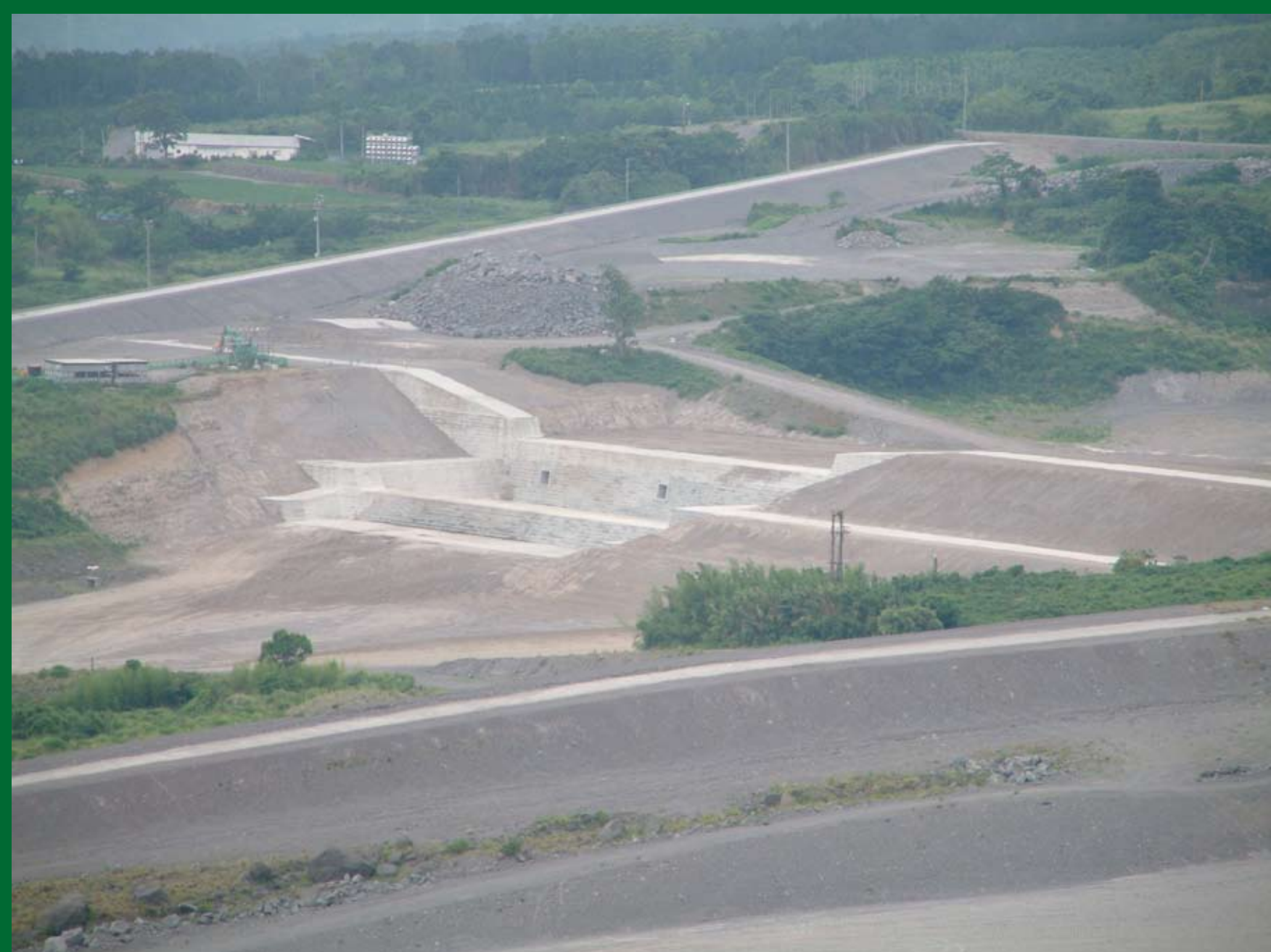
赤松谷川4号床固工 [2006/09]
