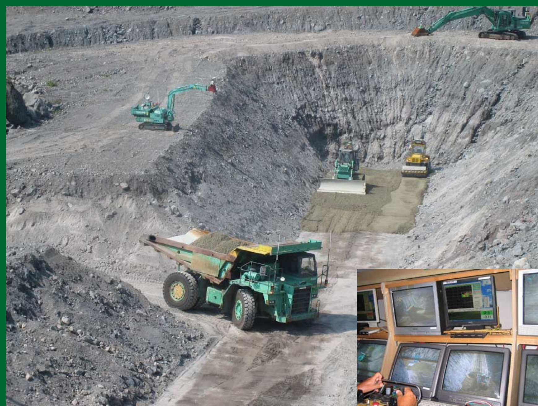
おしが谷砂防えん堤（RCC 打設） [2009/08]
