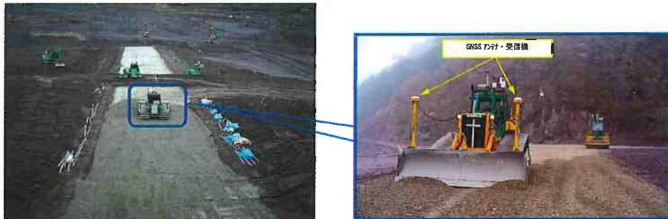
写真-3 遠隔操作式ICTブルドーザによる敷き均し作業状況
